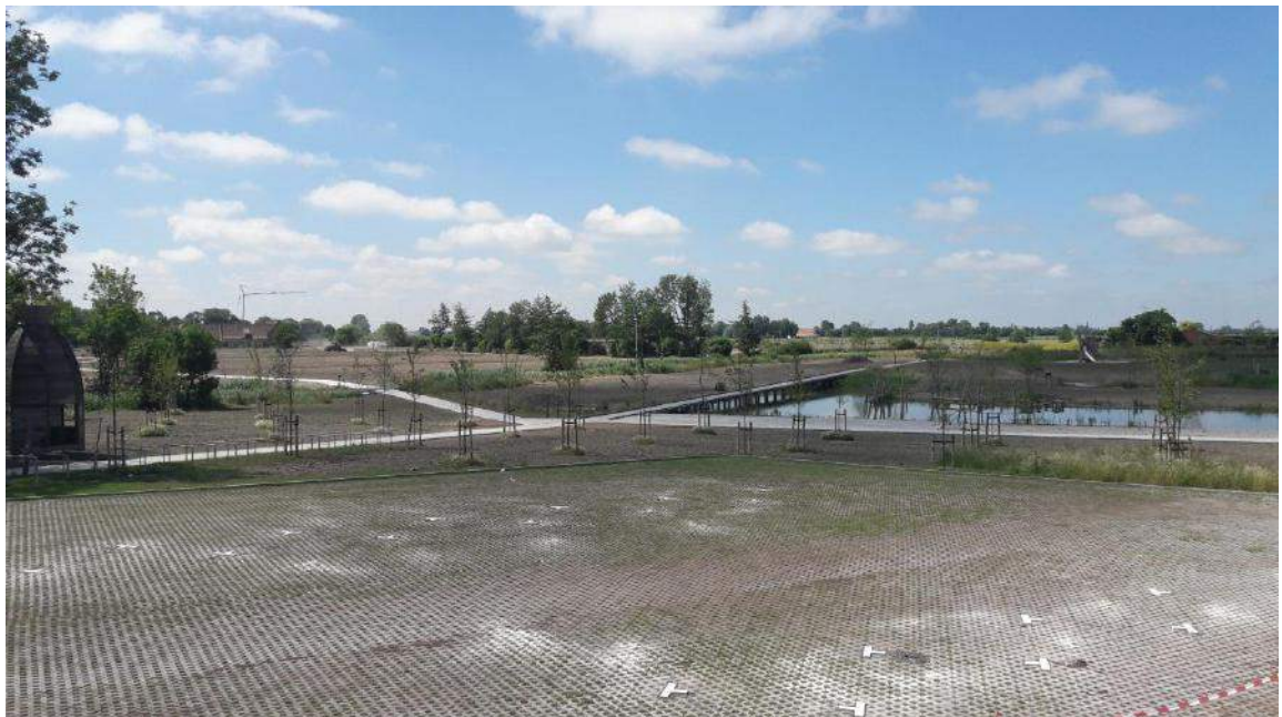
Afbeelding 2.9: zicht op het domein kort na de aanleg (25 juni 2018).
